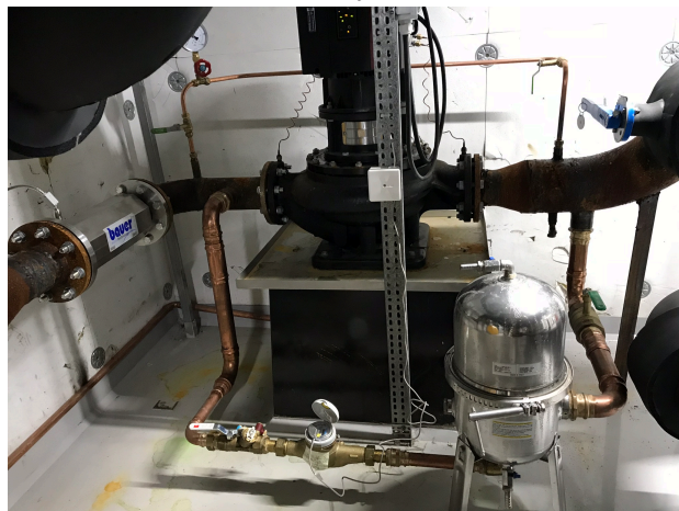
installation vid pumpens trycksida i rörböjen eller under röret
