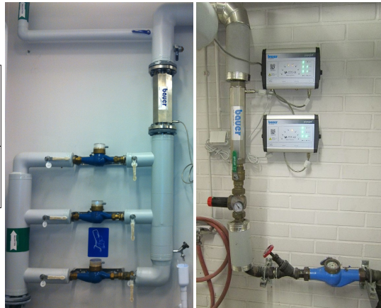
Installation i slutet kretslopp direkt på röret
