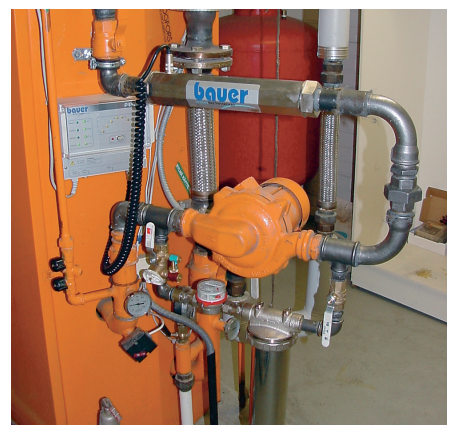
Installation direkt på röret & filter under pumpen
