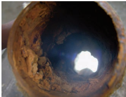
Galvaniserade kallvattenrör innan Bauer vattenbehandling har installerats
