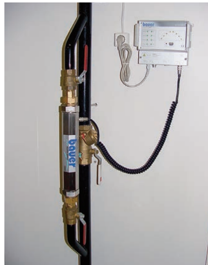
Installation med förbikoppling
