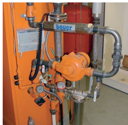
Installation direkt på röret
