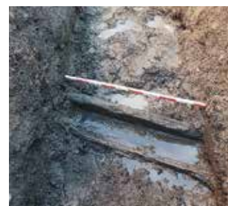
Spår av Uppsalas första och äldsta vattenledningar.
