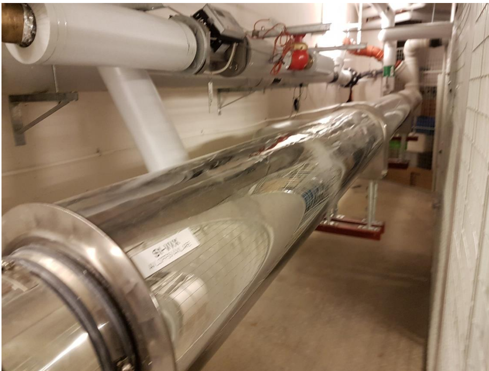
Värmeväxlaren består av 1 liggande 200 mm värmeväxlare är motströmskopplade
