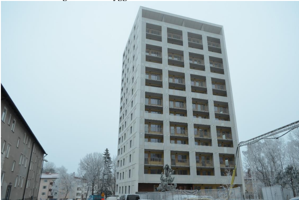
Valvankaret Högdalen Riksbyggen
