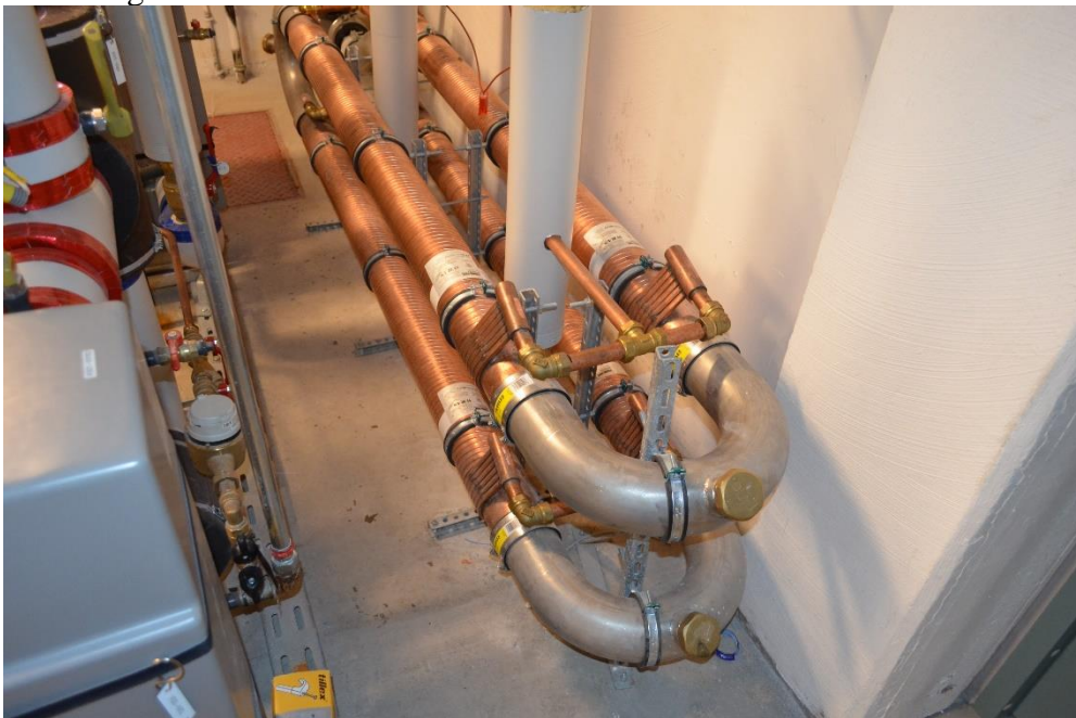
Värmeväxlaren består av 4 liggande 60" Power-pipe och är motströmskopplade.
