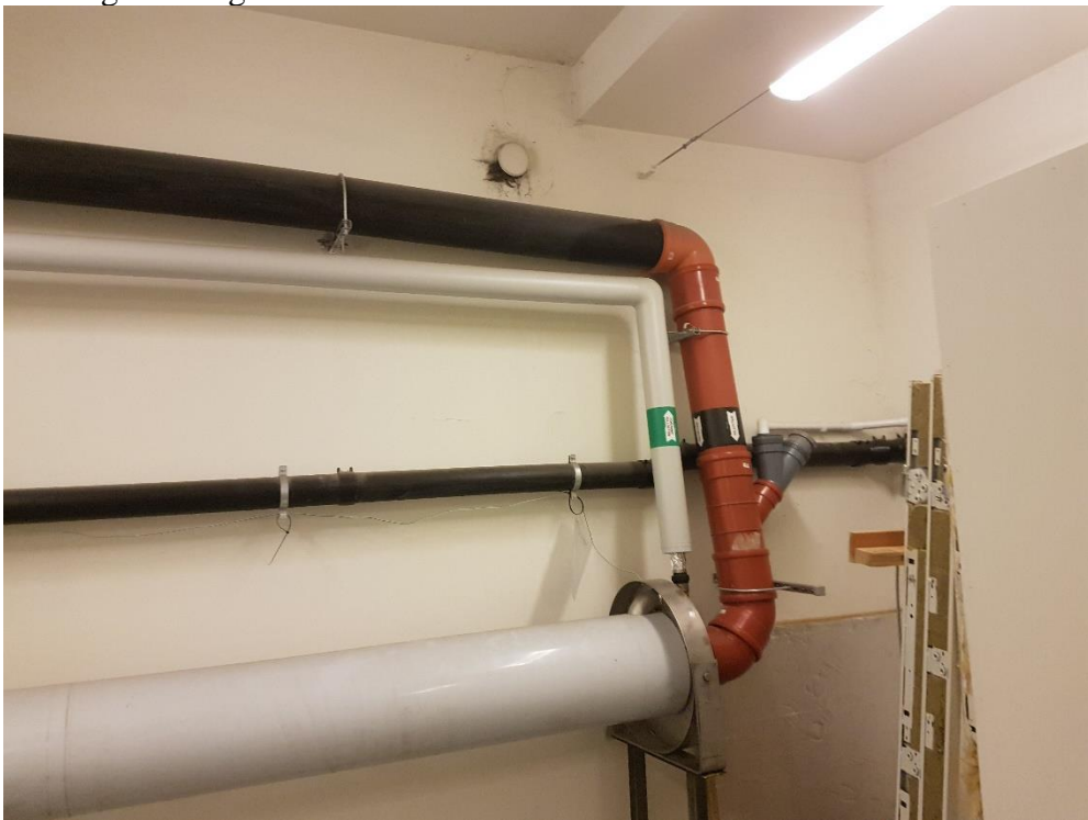
Värmeväxlare liggande Fendergatan 2
