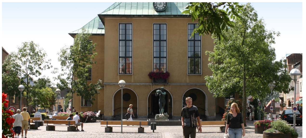
Tack vare integrerad kyla i luftbehandlingsaggregaten kunde rådhuset i Sønderborg behålla sin vackra arkitektur.
