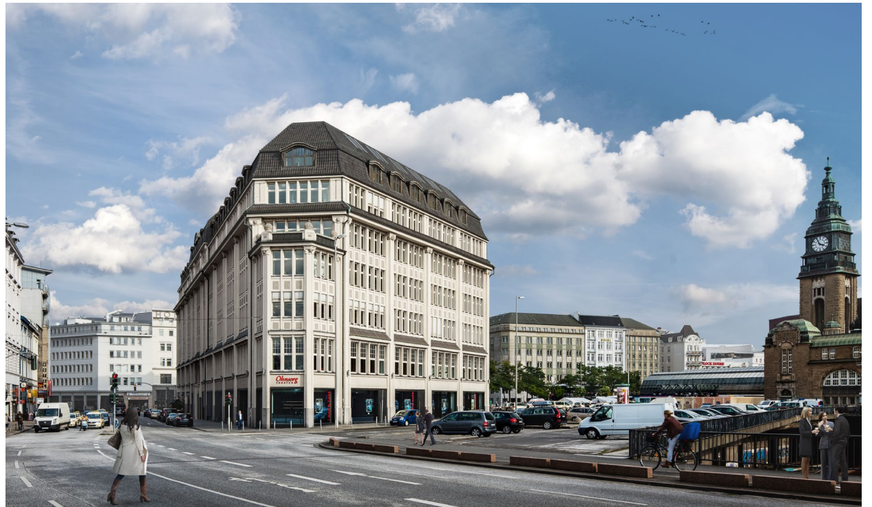
Den ståtliga byggnaden Bieberhaus i Hamburg ventileras med hjälp av åtta Envistar Top-aggregat från IV Produkt.
