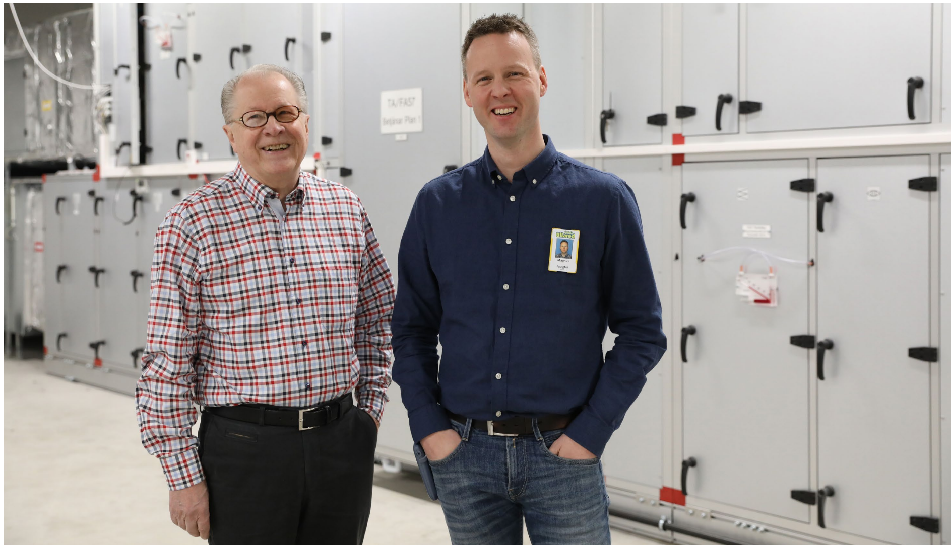
Nils Perlhagen och Magnus Larsson har under många år hjälpts åt att projektera och sköta Gekås stora samling med ventilationsaggregat från IV Produkt, nu över 100 stycken.
