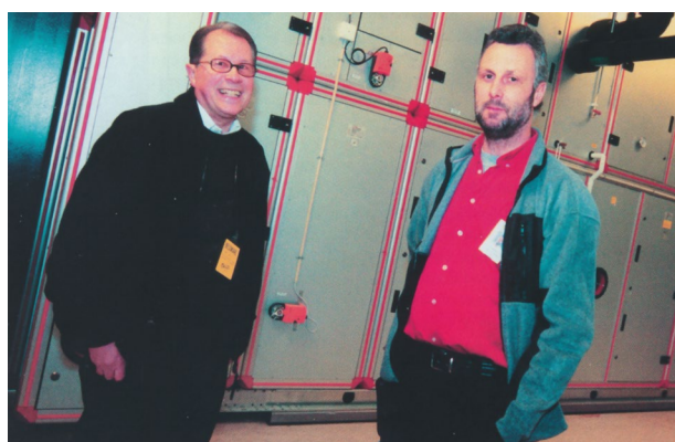
Redan under 90-talet var inomhusklimatet viktigt på Gekås. Nils Perlhagen syns här i ett fläktrum med dåvarande bygg- och fastighetschef Tommy Johansson.
